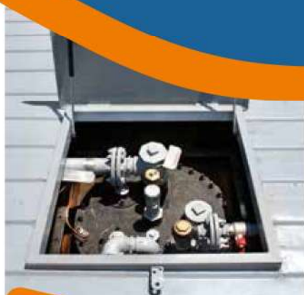
Ανθρωποθυρίδα δεξαμενής με καπάκι βαρέως τύπου
